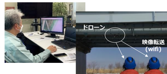
UAVによる橋梁のリモート点検システム
