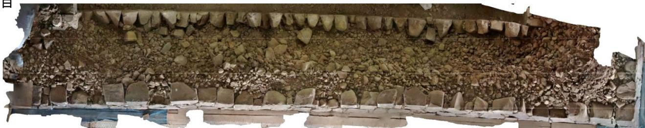
大天守台内面の昭和31年と明治22年崩落後の積み直し範囲は、使用している築石の石材が小さく、下段ほど間知石状の石材が増える傾向がある。
