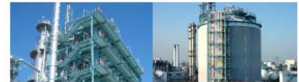
＞ 石油・石油化学プラント
