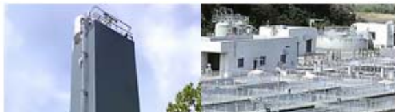
＞ 水処理プラント
