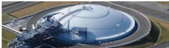
＞ 受入・貯蔵設備
